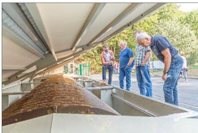
Marcus Heinemann (links), Fachbereichsleiter bei der EW Wasser, erläutert die Funktionsweise der Scheibentauchkörper der naturnahen Kläranlage Thalwenden.
